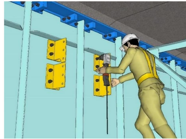
桁下でスプリットTの設置。 合成桁の場合、仮設部材も設置
