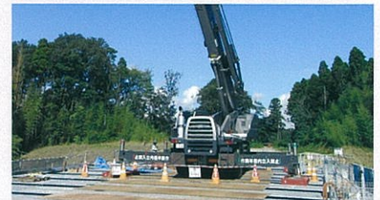
鋼殻パネル上からの架設状況
